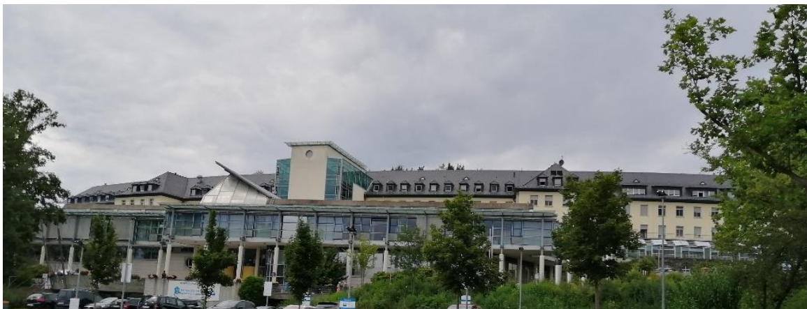
Das ehemalige „Versorgungskrankenhaus“ Hohe Warte im Jahr 2020, Foto: Eichmeier (M.E)
